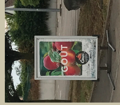
Dispositif installé sans ancrage au sol
