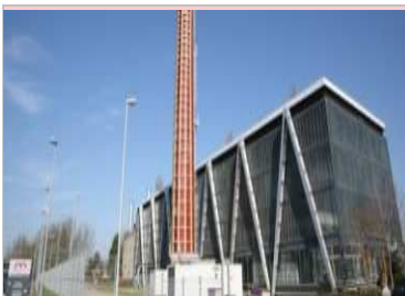
Centrale thermique de l'Illberg
